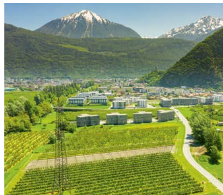
La ligne aérienne provisoire de 380 kV La Bâtiaz – Le Rosel, juillet 2020
