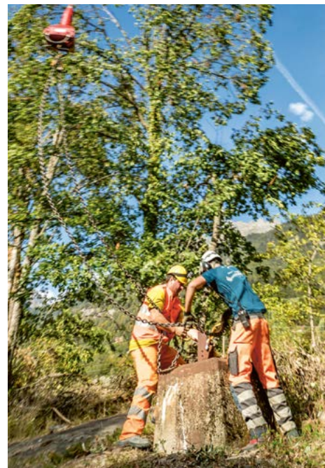
Démontage de l’ancienne ligne de 220 kV à Salvan, septembre 2018
