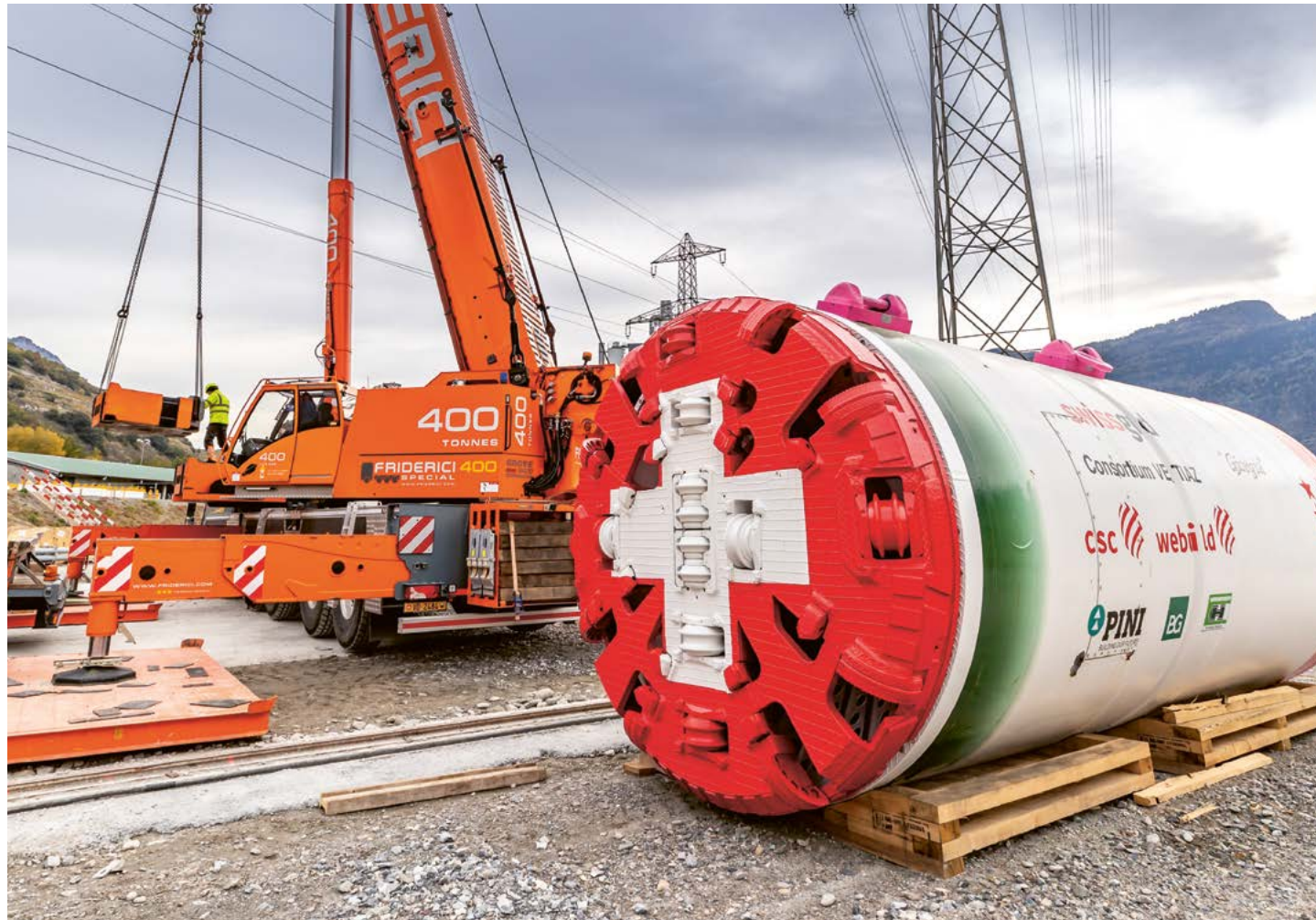
Giorgia, le minitunnelier, sur la place de chantier du Verney, octobre 2020
